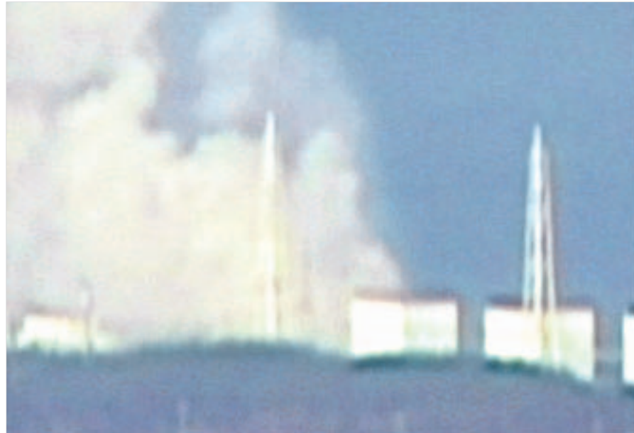
Der Supergau: Am 12. März 2011, einen Tag nach Tsunami und Erdbeben, explodiert einer der Kühltürme des Kernkraftwerks Fukushima. Fotos: dpa
