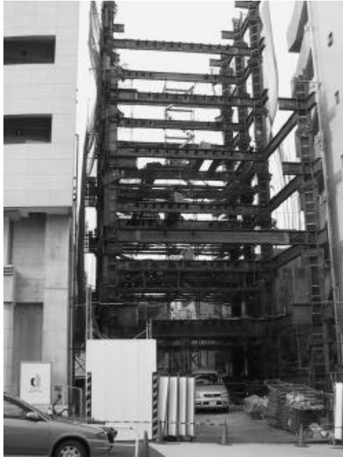
Abb. 6: Baustelle im Zentrum von Tōkyō
